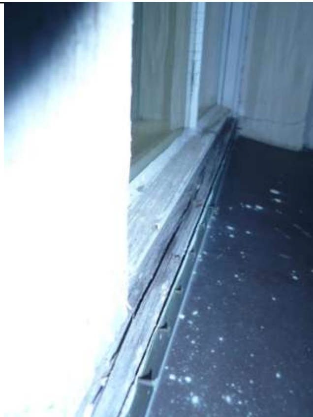
okno č. 6 – popraskaný spodní rám (podobně okna č.8,13,14,19,20,27-29,31,32,37,39)
