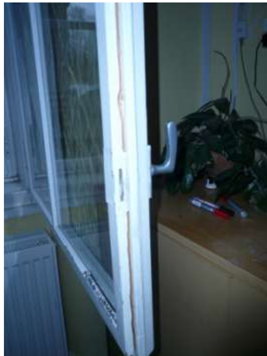
okno č. 1 – přeplech. klička, drážka po těsnění
