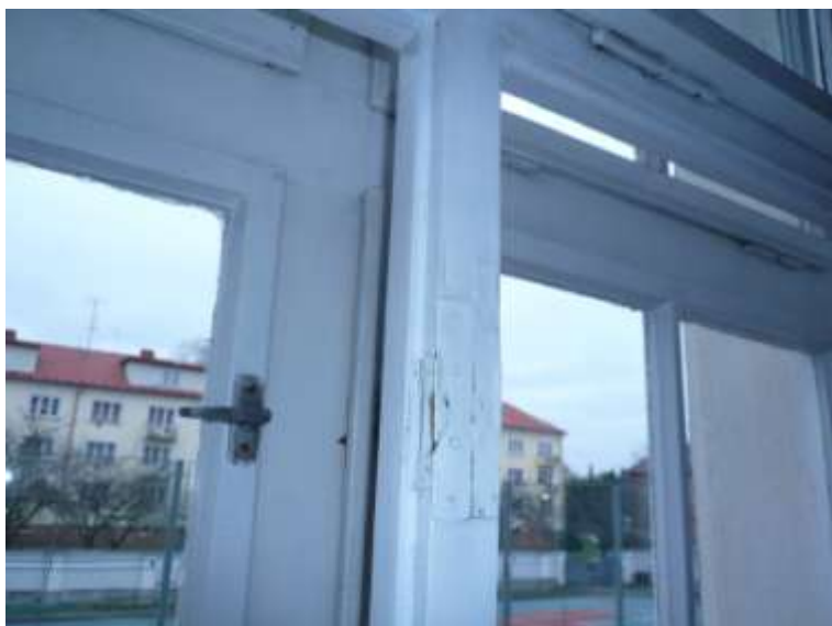
okno č.30 – chybí kování u střední příčky
