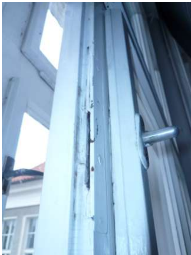
okno č. 20 – poškozené střední příčky rámu u kování , přeplechováno
