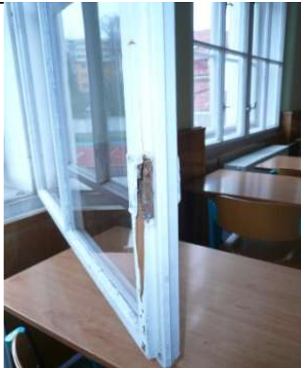
okno č. 26 – poškozené vnitřní křídlo
