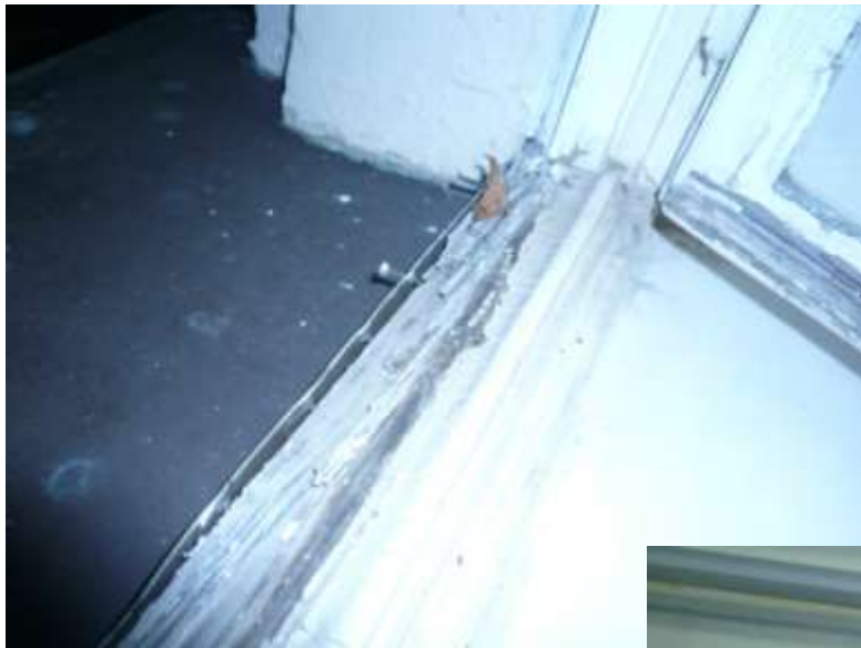
okno č. 8 – popraskaný spodní rám (podobné poškození i u okna č.13,14,19,20,27-29,31,32,37,39)
