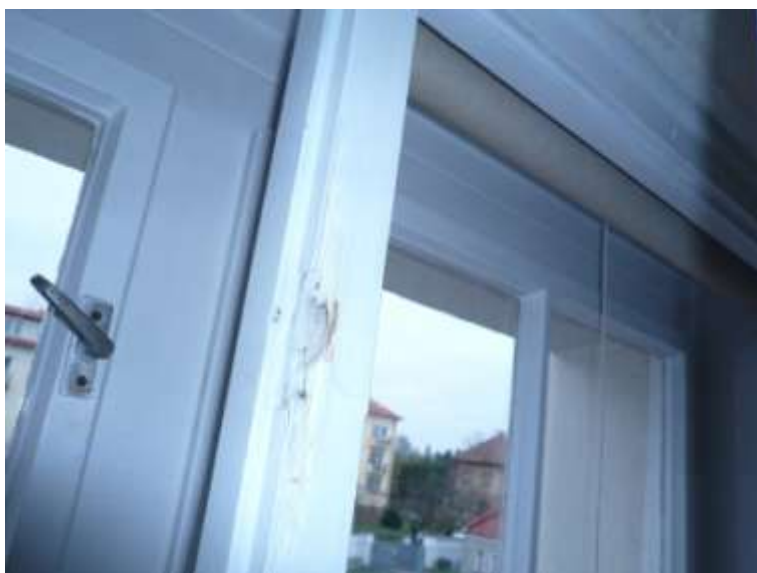
okno č.30 – chybí kování u střední příčky
