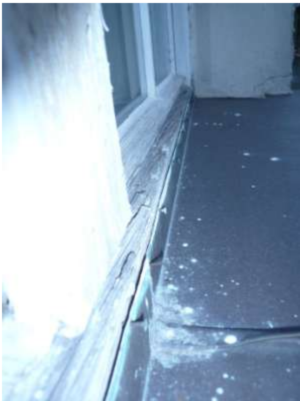
okno č. 2 – silně popraskaný rám, uvolněný plech
