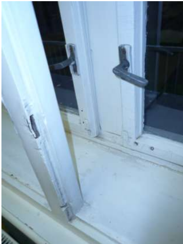
okno č. 5 – poškozené kování ve střední příčce
